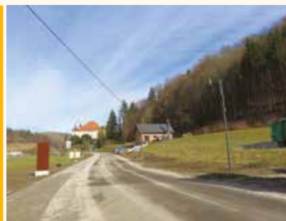
Obnova ceste Svečina – center
