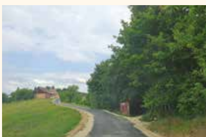
JP 695421 – Čajžič: asfaltiranje v dolžini 1.560 m
