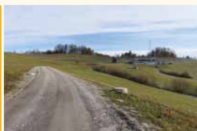
JP 695262 – odcep vodohran Grušena: asfaltiranje v dolžini 250 m
