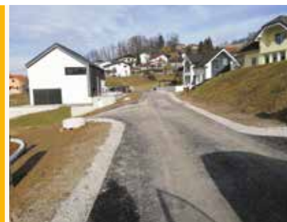
JP 695934 – Matjašič–Ul: asfaltiranje v dolžini 170 m
