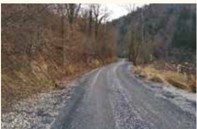
JP 695152 – odcep Marko: protiprašna zaščita v dolžini 290 m
