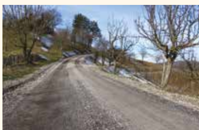
JP 695181 – Pesnica 11: asfaltiranje v dolžini 400 m
