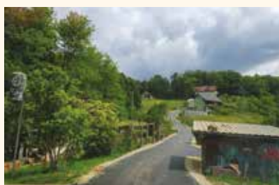
JP 695662 na Plintovcu–odcep Točaj: asfaltiranje v dolžini 250 m
