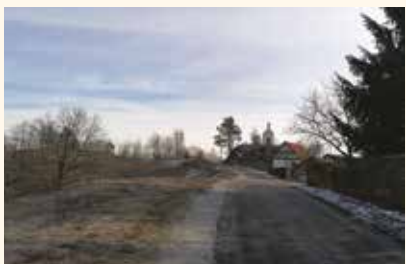
LC 195131 – Gradiška I–Sp. Dobrenje: asfaltiranje v dolžini 873 m
