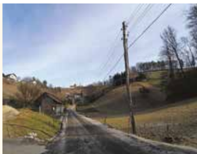
JP 695841 – Velički–Mesarec: asfaltiranje v dolžini 716 m
