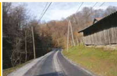
JP695081 – Šac–Hrastnik–Veliki Kozjak: asfaltiranje v dolžini 480 m
