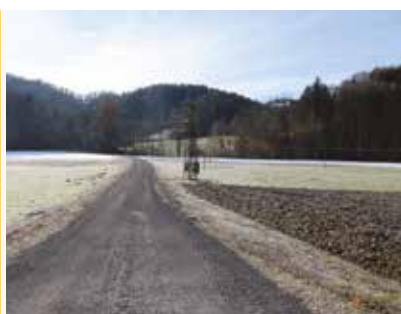
JP 695211 – odcep Vajda–Borko: protiprašna zaščita v dolžini 300 m
