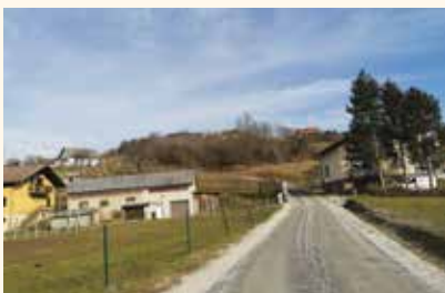
JP 695991 – odcep v Hrib–Gradiška III: asfaltiranje v dolžini 402 m
