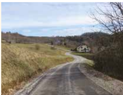
JP 695521 – Plač–Kovačič–Kresnica: asfaltiranje v dolžini 772 m
