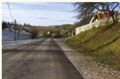
JP 695412 – Novo naselje: asfaltiranje v dolžini 210 m
