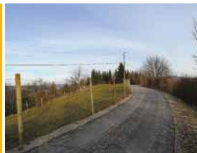
JP 695621 – Plintovec–odcep Krištof Marksl: asfaltiranje v dolžini 1.430 m
