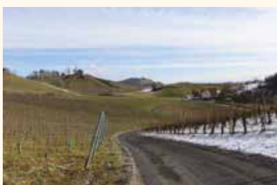
JP 695331 – odcep Jamšek–Purgaj: protiprašna zaščita v dolžini 367 m
