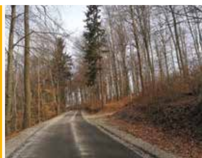
Odsek Fifolt–cerkev: asfaltiranje v dolžini 900 m
