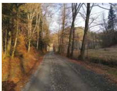
JP 695641 – Duhova graba: protiprašna zaščita v dolžini 1.500 m
