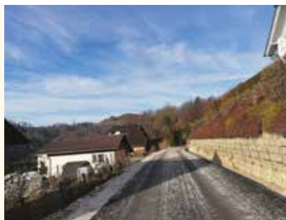
JP695813 – odcep Gaube: asfaltiranje v dolžini 140 m
