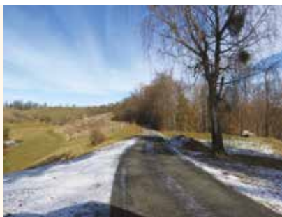
JP 695261 – Jurij–Grušena: protiprašna zaščita v dolžini 750 m
