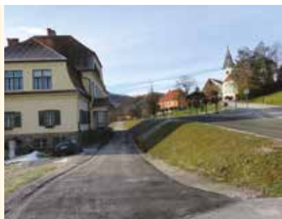
Nktg–cesta mimo VS Jurij: asfaltiranje v dolžini 120 m
